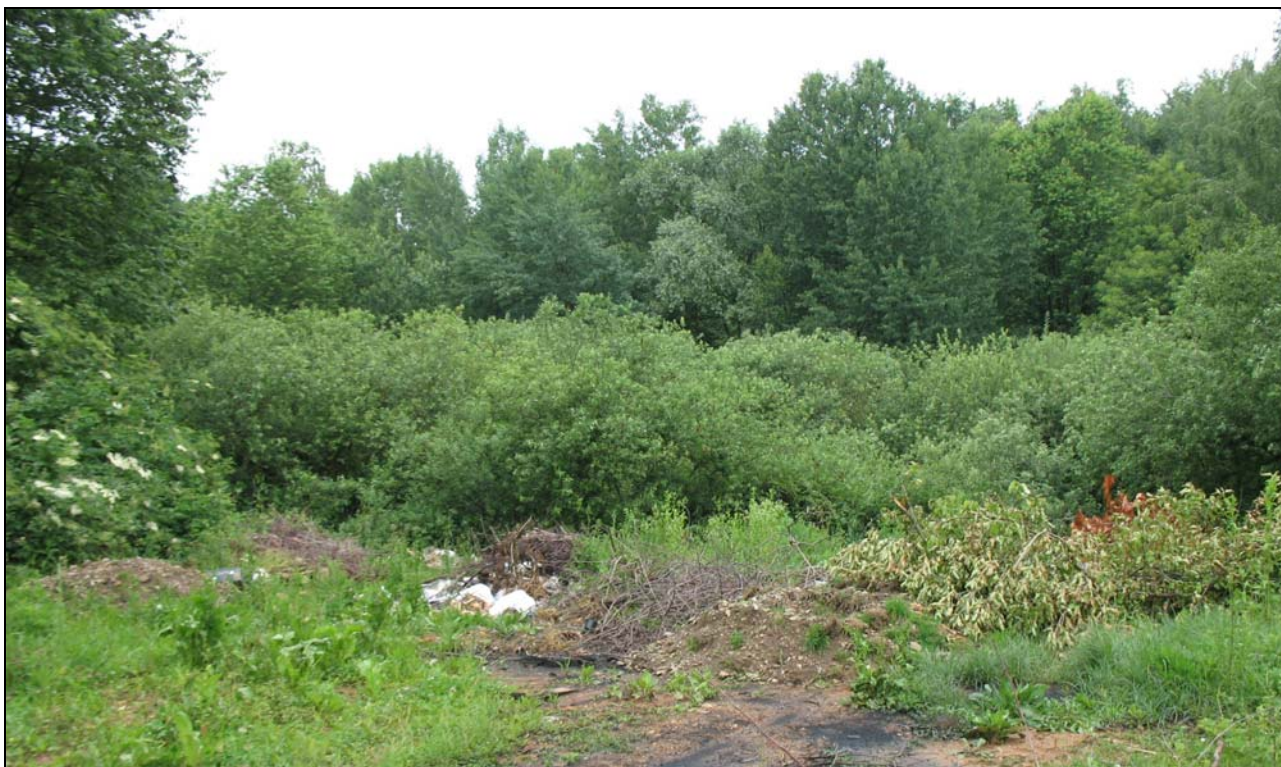
Slika 3: Pogled s ceste. Dno in brežine kala so se gosto zarasle z grmovjem in drevesi. Ob cesti je vidna deponija materiala.
